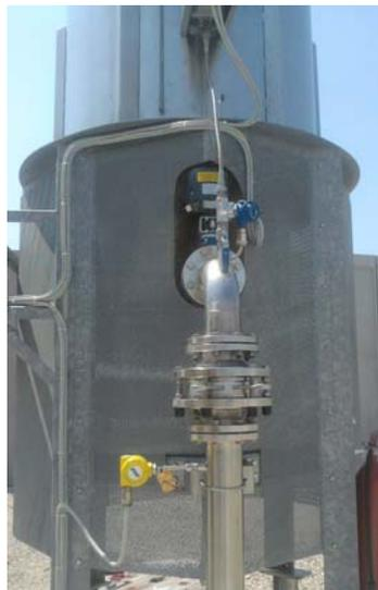
Arrestatore di fiamma, valvola gas e
