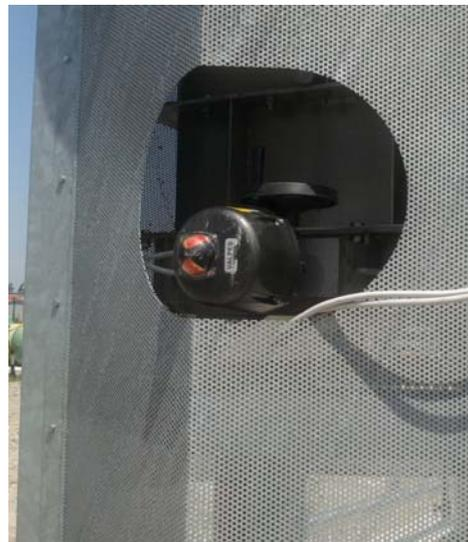
Attuatore elettrico per presa aria di
