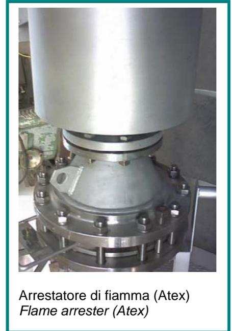
Arrestatore di fiamma (Atex)
