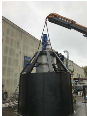
Miscelatore in prova Testing the mixer
