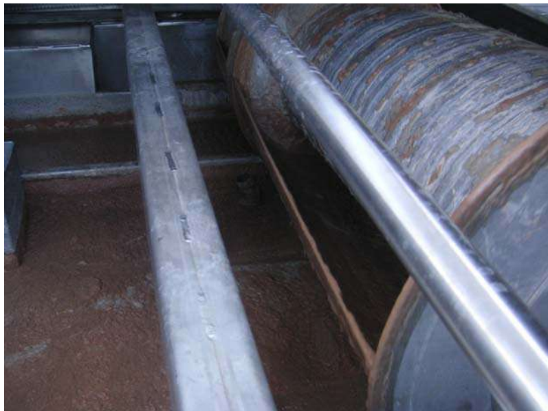
SCHIUMATORE ROTANTE ROTATING SKIMMER
